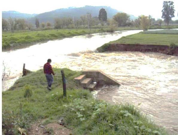
**Ilustración 2. Ruptura jarillón del Río Chicamocha y desbordamiento del Canal Vargas. Fuente: CLOPAD Duitama, 2010.**
